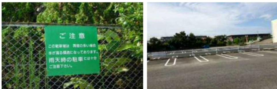
大規模開発による調整池の設置例（掘り下げられ平常時は駐車場として利用）
