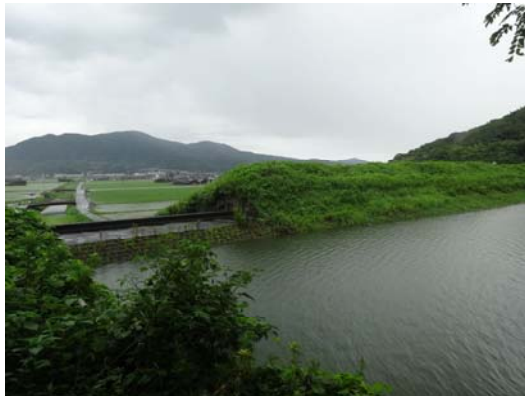
写真5 永池下ため池の写真
